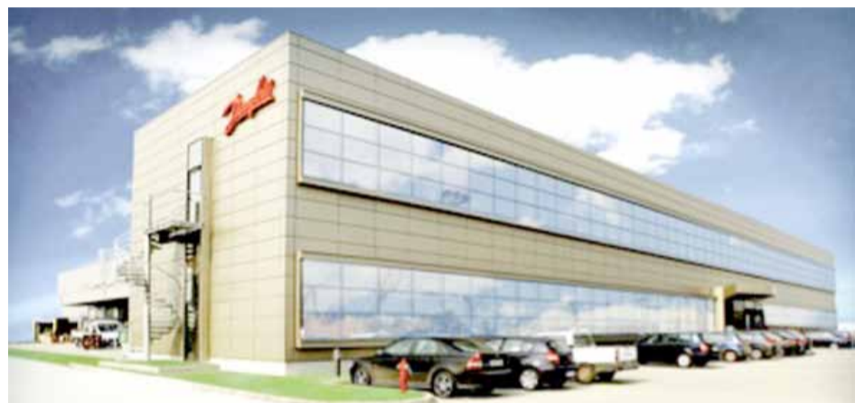
Noul sediu Danfoss District Heating în Popești-Leordeni, România
